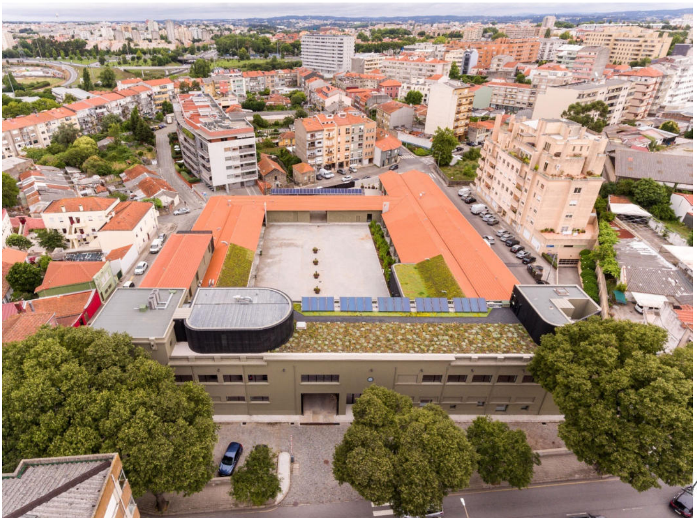
↑ Legenda: Edifício São Dinis - Instalações das empresas municipais GO Porto e EMAP
